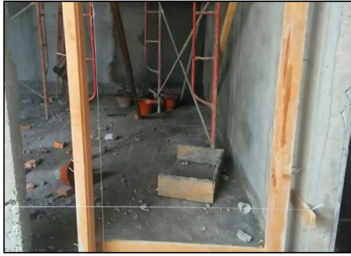
Gambar 4. 13 Pemasangan Kusen Kayu
