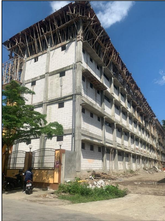
Gambar 4.2 Foto Bangunan Proyek
