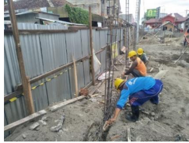
Gambar 4.11 Penulangan Pada Kolom Dan Sloof
