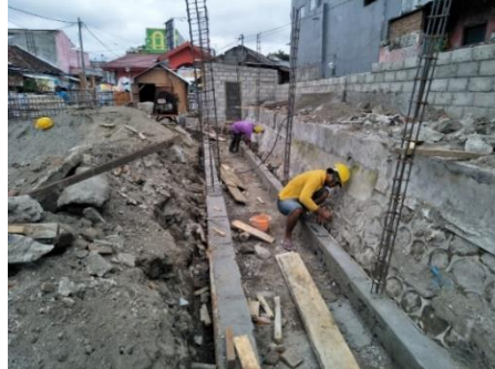
Gambar 4.8 Proses Pembongkaran Bekisting Sloof
