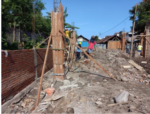
Gambar 4.12 Pemasangan Bekesting Pada Kolom
