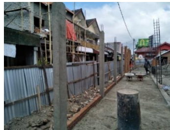
Gambar 4.16 Pembongkaran Bekisting Kolom
