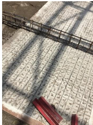
Gambar 4.10 Pembuatan Tulangan Kolom
