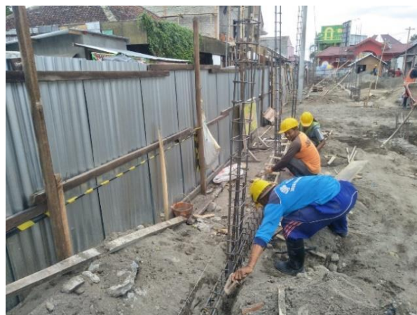
Gambar 4.3 Proses Penulangan Sloof dan Kolom
