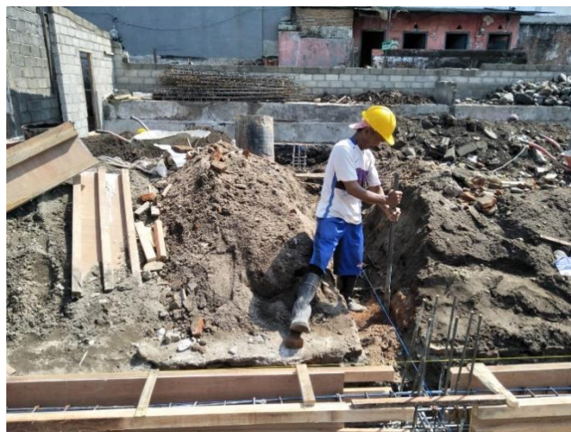
Gambar 4.5 Proses Pemasangan Bekisting Sloof
