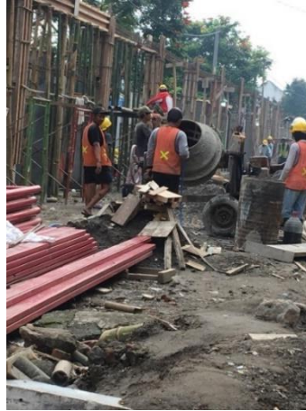
Gambar 4.14 Proses Pengecoran Kolom
