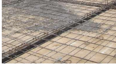
Gambar 2. 8 Plat Lantai Beton (sumber: Dokumentasi Pribadi)
