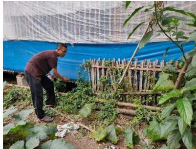
Gambar 4. 5 Dinding Kandang di Peternakan Kandang Rahayu
