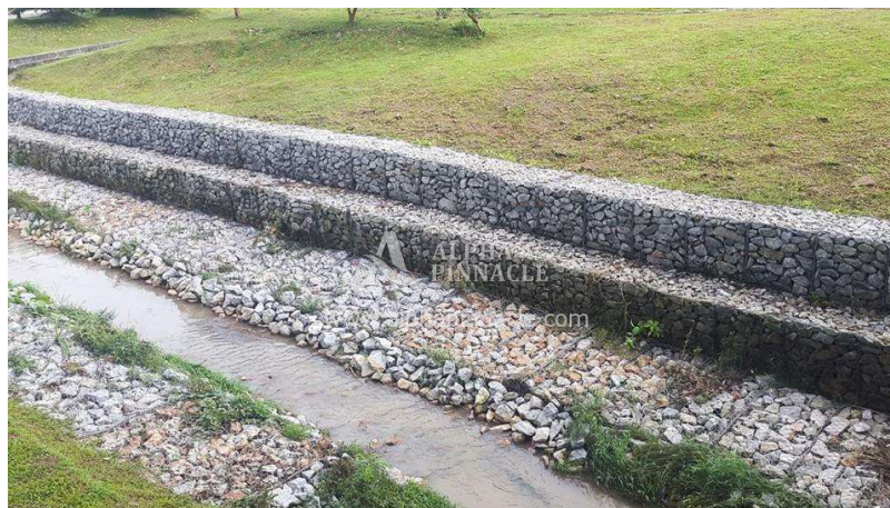
Gambar 2.16 Penerapan Gabion atau Bronjong di Dasar Sungai
