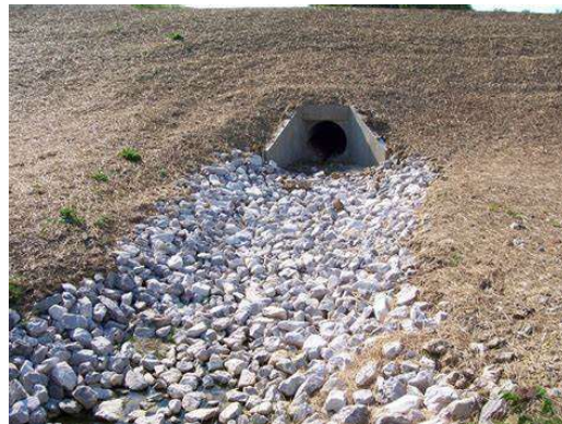
Gambar 2.14 Gambar Riprap pada dasar aliran air
