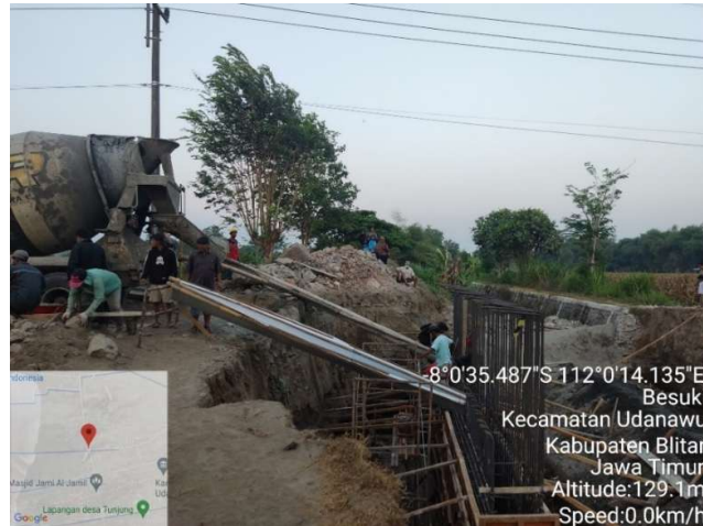
Gambar 4.6. Beton Segar Dimasukan ke Bekisting
