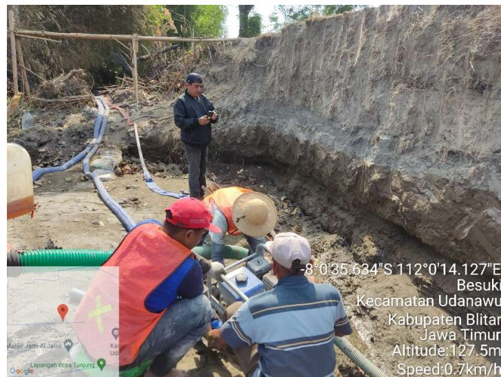
Gambar 6.10. Pemompaan Genangan di Pondasi Talud Tepi Sungai
