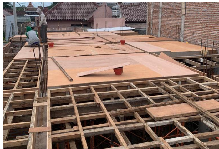
Gambar 4.5 pemasangan Balok kayu dan Plywood
