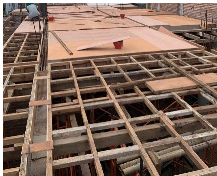
Gambar 2.5 pemasangan bekisting pelat lantai
