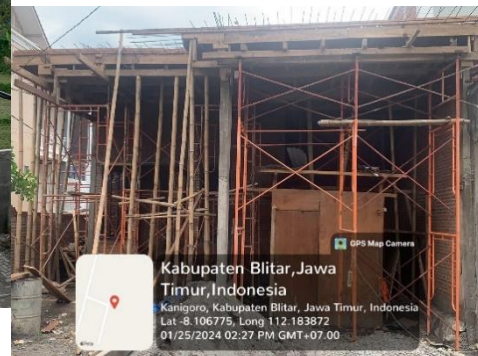
Gambar 3.8 Bekisting Balok dan Pelat Lantai
