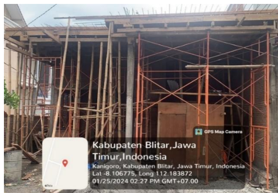
Gambar 2.6 pemasangan perancah (scaffolding)
