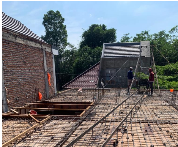
Gambar 2.7 pengecoran pelat lantai beton konvensional
