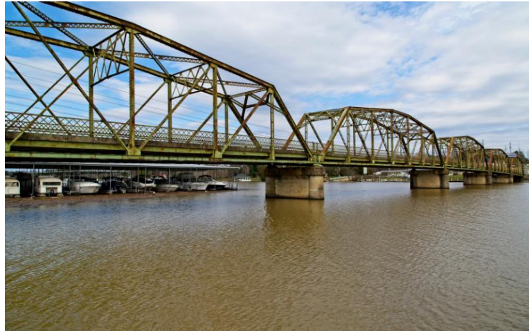
Gambar 2.3 Jembatan Baja (Sumber : https://histeel.co.id/ )
