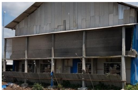
Gambar 15. Celldeck dan Blower
