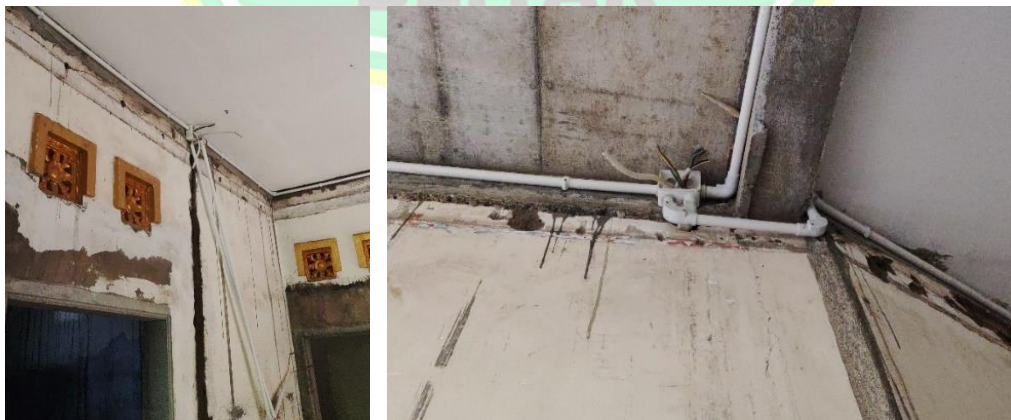
Gambar 8 Instalasi Listrik Rumah Lantai 1
