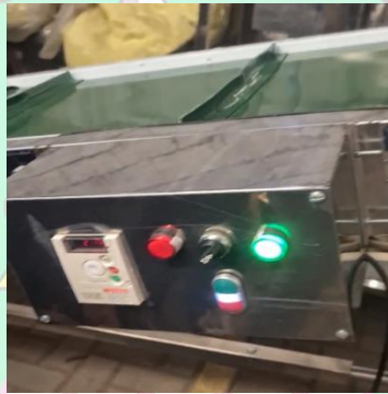
Gambar 2 Pemasangan panel pada rangka
