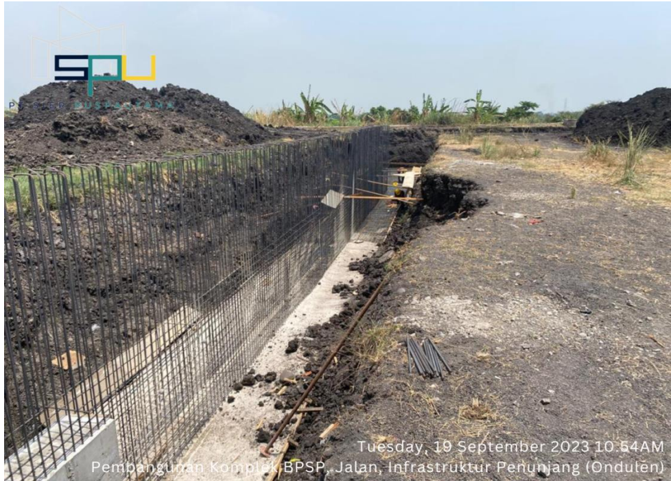
Lampiran 2.5 Survei Pekerjaan Penulangan untuk Dinding Bozem
