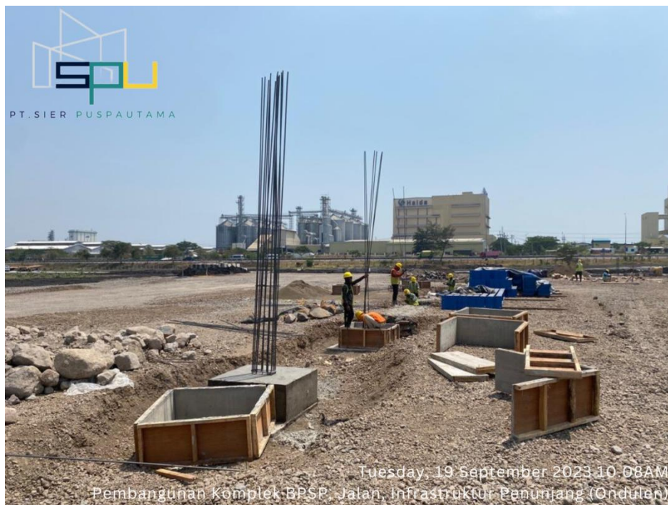
Lampiran 2.4 Survei Pekerjaan Pemasangan Pilecap Kolom
