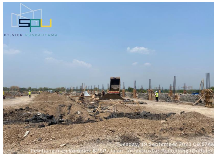
Gambar I.7 Survei Pekerjaan Struktur pada Pembangunan Komplek Bangunan Pabrik Siap Pakai (BPSP), Jalan & Infrastruktur Penunjang di Jl. Kraton Industri III No. 14 A, B, C Kawasan PIER II Pasuruan
