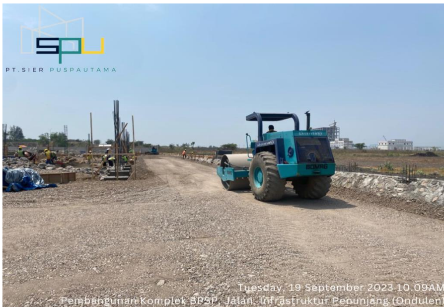
Lampiran 2.2 Survei Pekerjaan Pematatan Jalan
