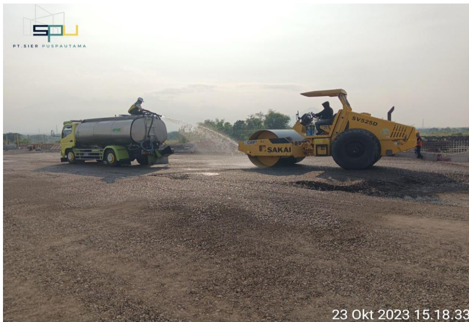
Lampiran 2.10 Survei Pekerjaan Pemasangan Sirtu
