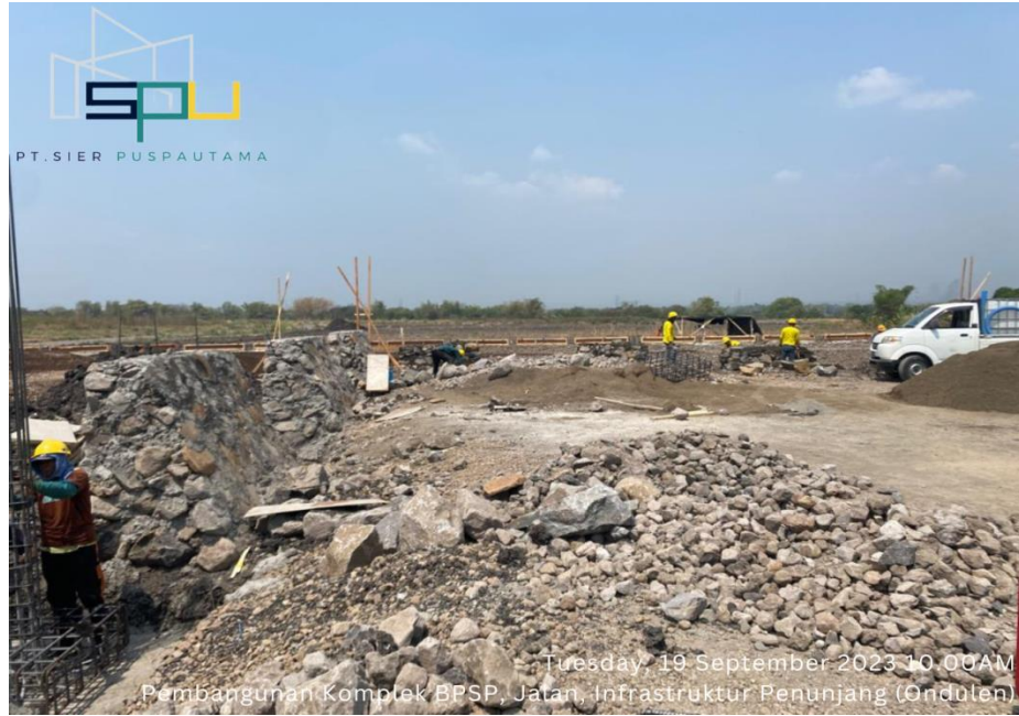
Lampiran 2.3 Survei Pekerjaan Pemasangan Pondasi
