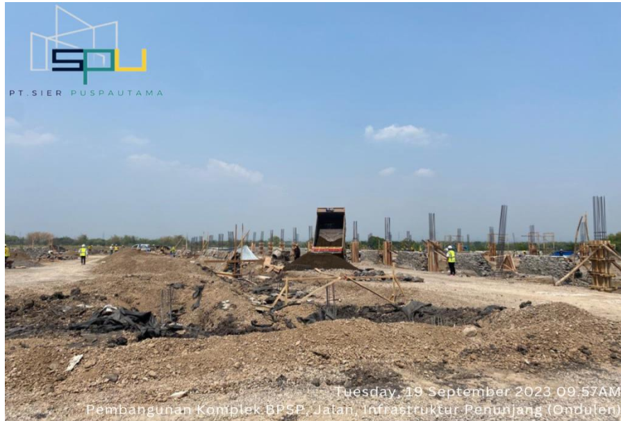
Lampiran 2.1 Survei Pekerjaan Galian Tanah Pondasi
