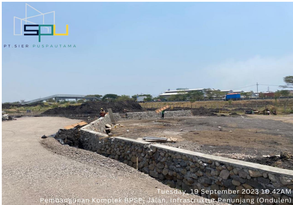
Lampiran 2.6 Survei Pekerjaan Pemasangan Dinding Penahan Tanah
