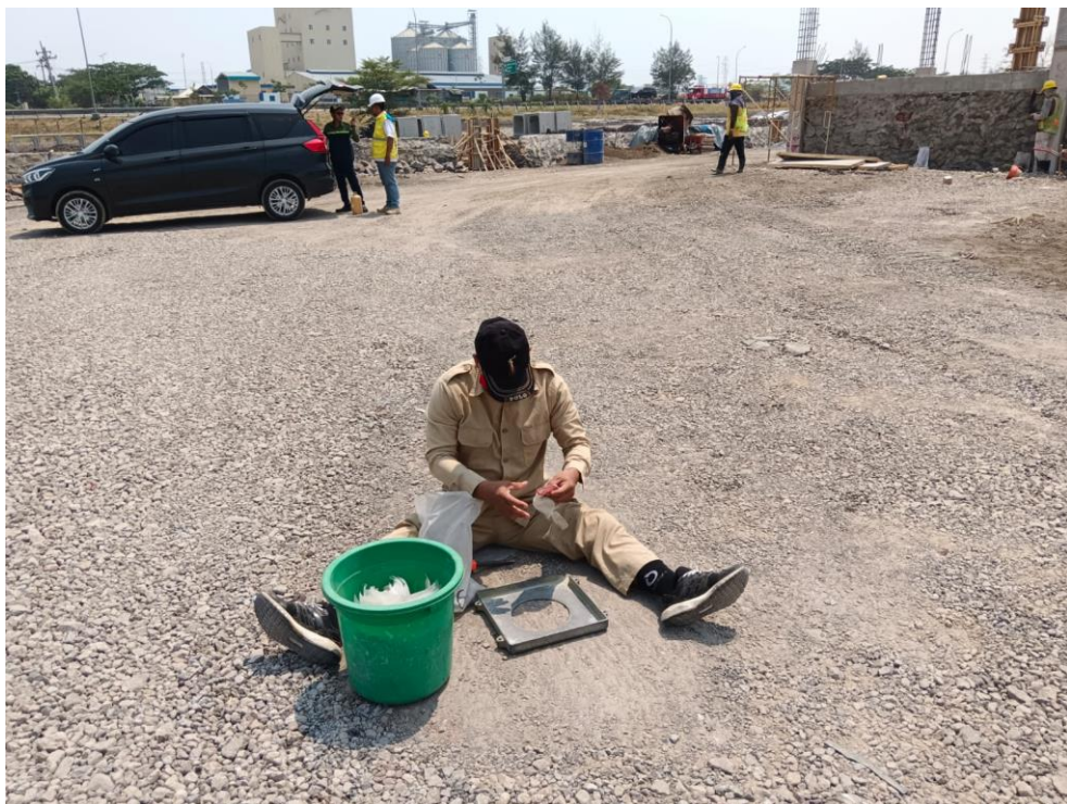
Lampiran 2.8 Survei Pekerjaan Pengujian Sandcone
