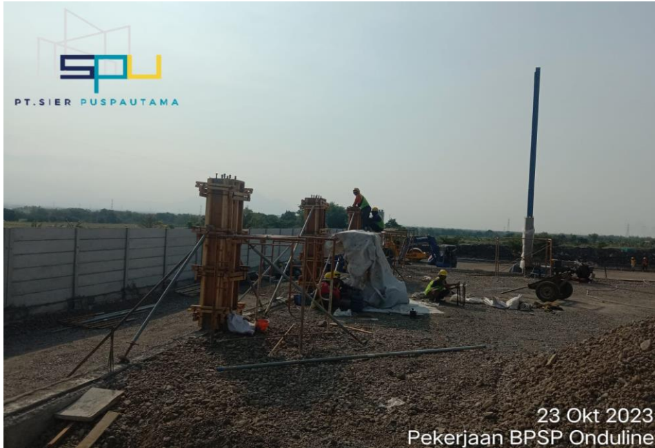
Lampiran 2.9 Survei Pekerjaan Pemasangan Kolom Bangunan
