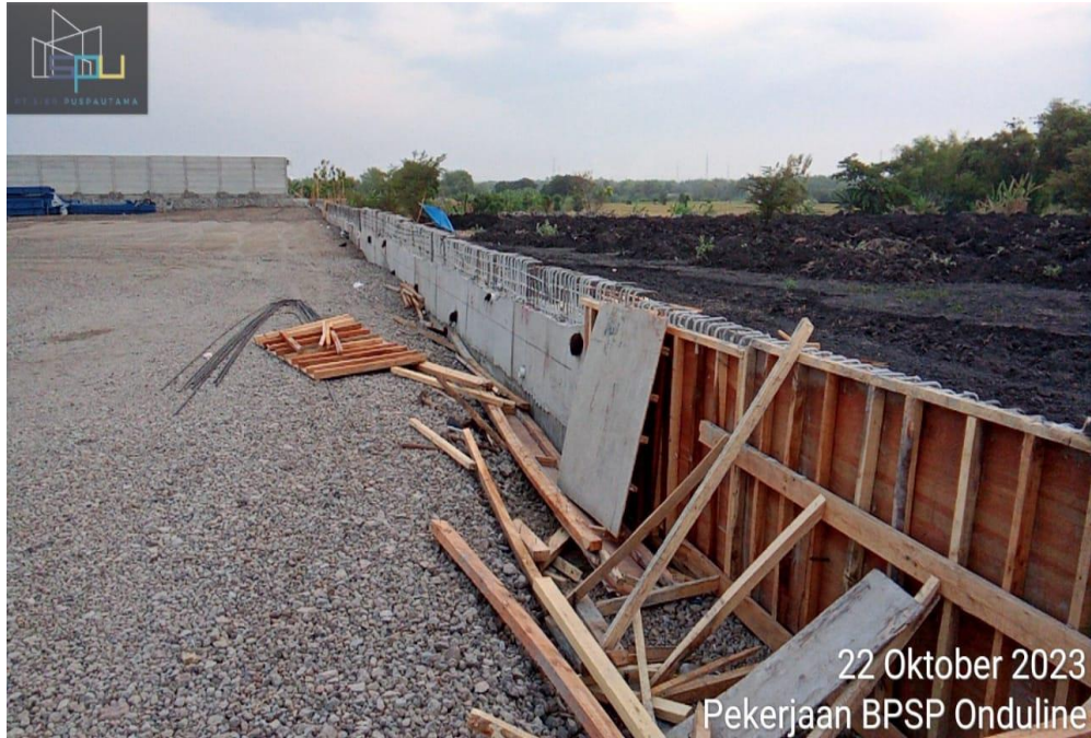
Lampiran 2.7 Survei Pekerjaan Pengecoran Dinding Pagar
