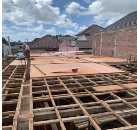
(Gambar 4.2 Pekerjaan Rangka Bekisting Plat)
