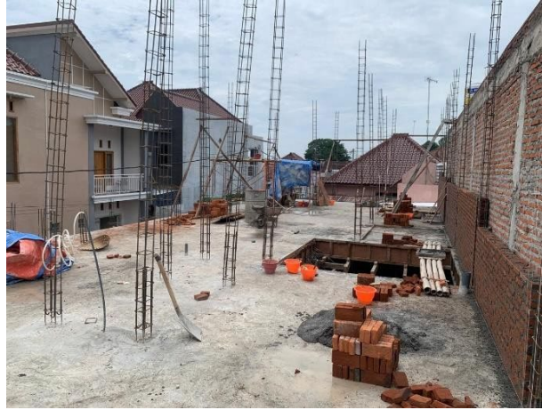
(Gambar 4.9 Perangkaian Tulangan Kolom)
