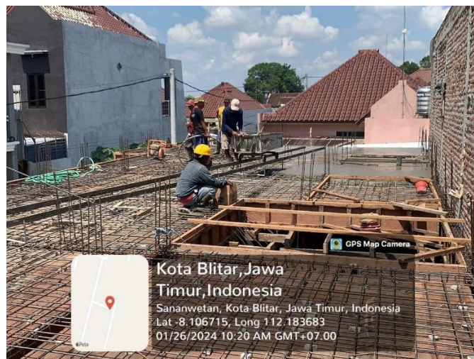
(Gambar 4.8 Pengecoran Plat dan Balok)
