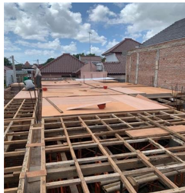
(Gambar 4.1 Pekerjaan bekisting balok)
