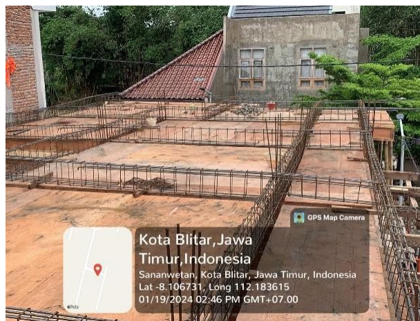
(Gambar 4.3 Perangkaian Tulangan Balok)
