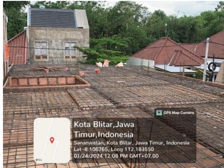
(Gambar 4.4 Pekerjaan Penulangan Plat)
