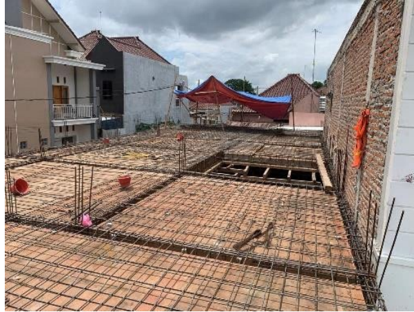
(Gambar 4.5 Perangkaian Tulangan Plat)
