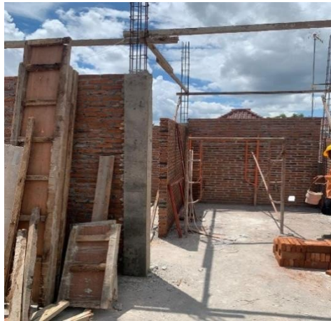
(Gambar 4.9 Hasil Pembongkaran Bekisting Kolom)
