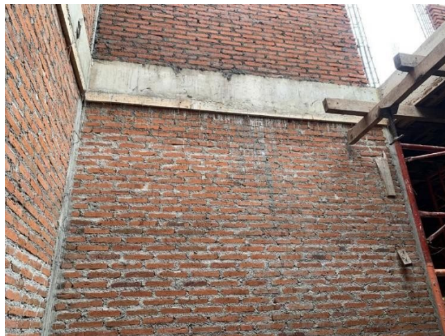
(Gambar 4.11 Hasil pembongkaran bekisting balok )
