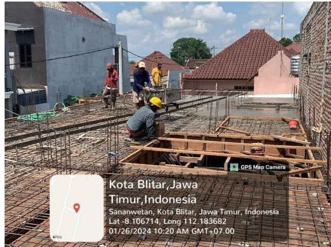
(Gambar 4.7 Pengecoran Plat dan Balok)
