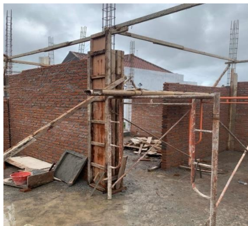
(Gambar 4.10 Pemasangan Bekisting Kolom)
