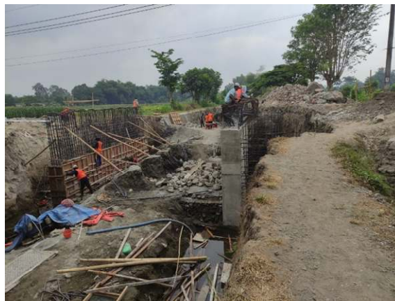
Gambar 4.21 Pemasangan Bekisting Abutment B dan Pembesian Abutment A
