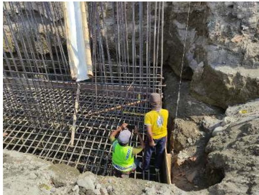
Gambar 4.17 Pekerjaan Pemasangan tulangan pondasi dan abutment
