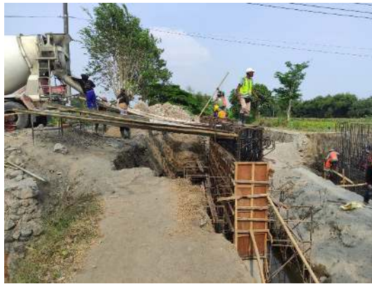
Gambar 4.25. Pengecoran Abutment A tahap 2
