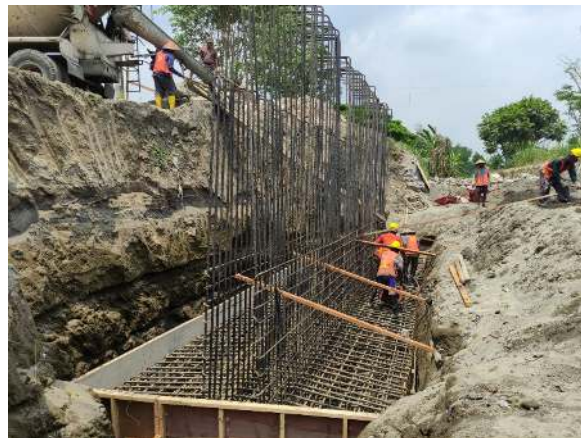
Gambar 4.27 Pembesian Searah dan Tidak Sesuai dengan Shop Drawing
