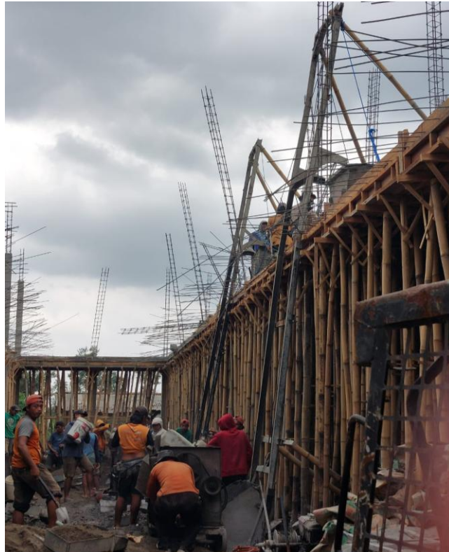
Gambar 4.6 Pengadukan dan Pengangkutan Campuran Beton (Sumber: Dokumentasi Lapangan)
