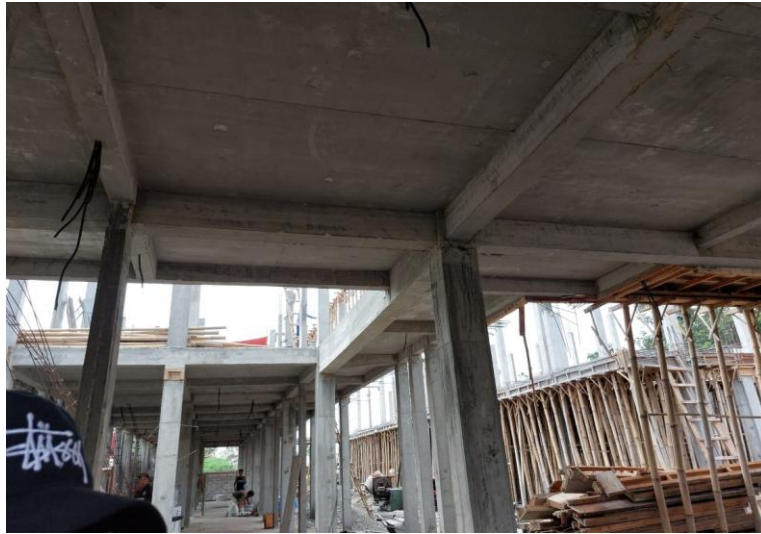
Gambar 4.8 Hasil Pengecoran Pelat Lantai dan Balok (Sumber: Dokumentasi Lapangan)
