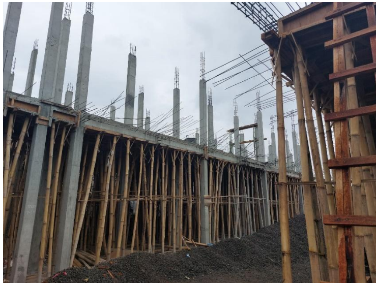
Gambar 3.2 Gambar Kondisi Pekerjaan Proyek (Sumber: Dokumentasi Lapangan)
