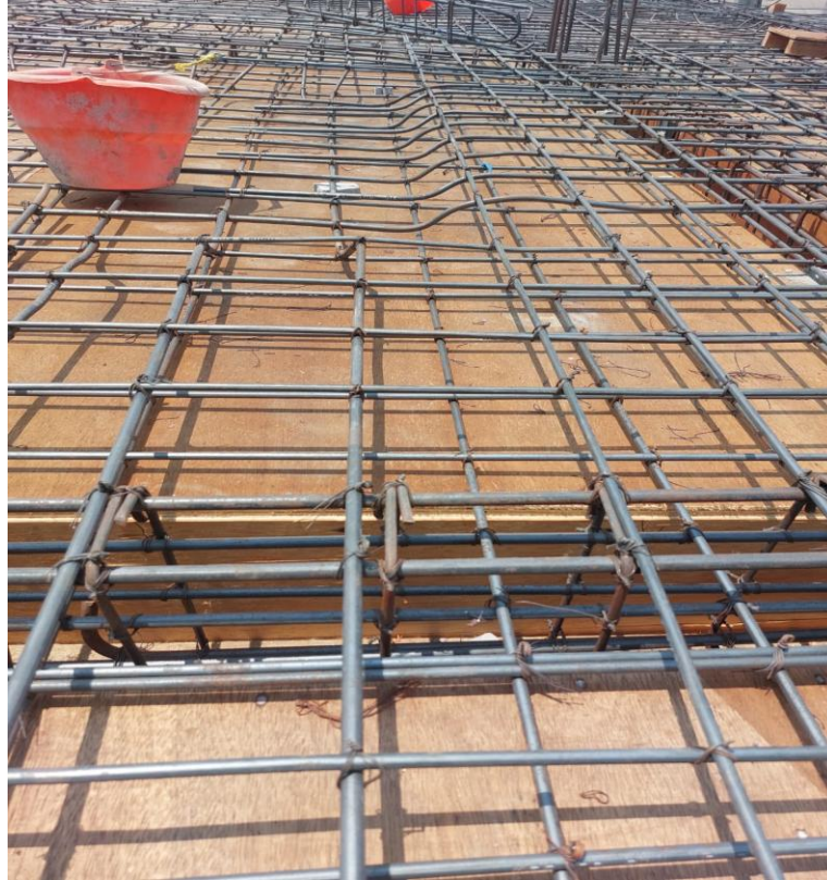
Gambar 4.5 Pemasangan Tulangan Pelat Lantai (Sumber: Dokumentasi Lapangan)
