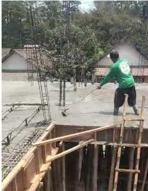
Gambar 4.7 Proses Pemerataan Adukan Beton (Sumber: Dokumentasi Lapangan)
