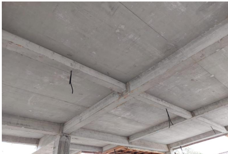
Gambar 4.9 Hasil Pengecoran Pelat Lantai dan Balok (Sumber: Dokumentasi Lapangan)
