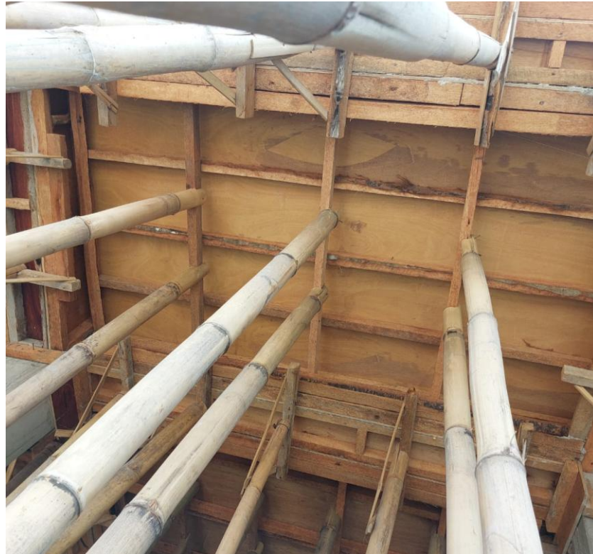
Gambar 4.4 Pemasangan Bekisting Pelat (Sumber: Dokumentasi Lapangan)
