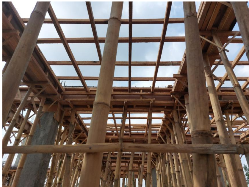
Gambar 4.3 Pemasangan Bekisting Pelat (Sumber: Dokumentasi Lapangan)
