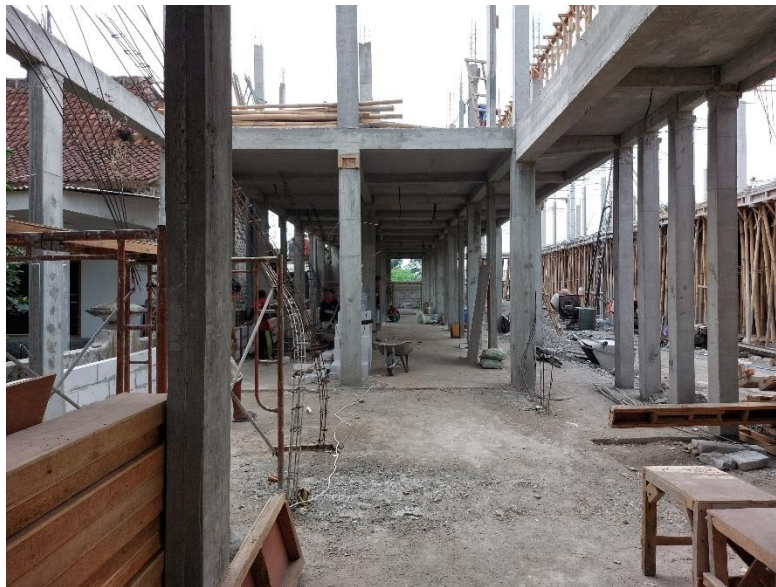
Gambar 4.7 Proses Pembongkaran Begisting Balok dan Pelat
