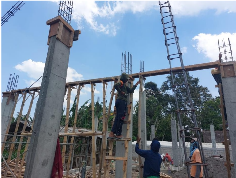
Gambar 4.4 Pemasangan Begisting Balok
