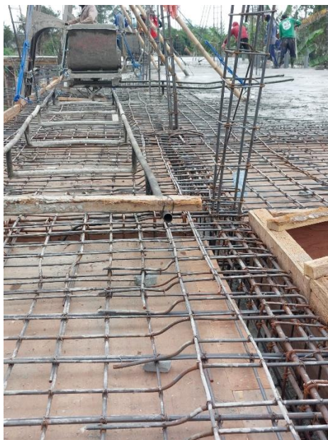
Gambar 4.6 Proses Pengecoran Pelat dan Balok
