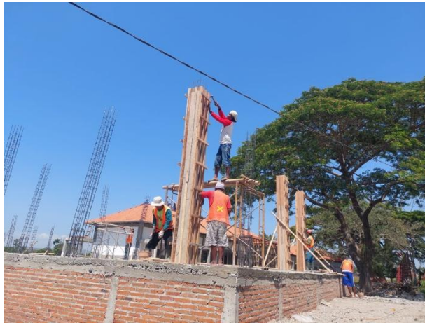
Gambar 4.18 Bekisting Kolom (Sumber : Data Lapangan, 2023)
