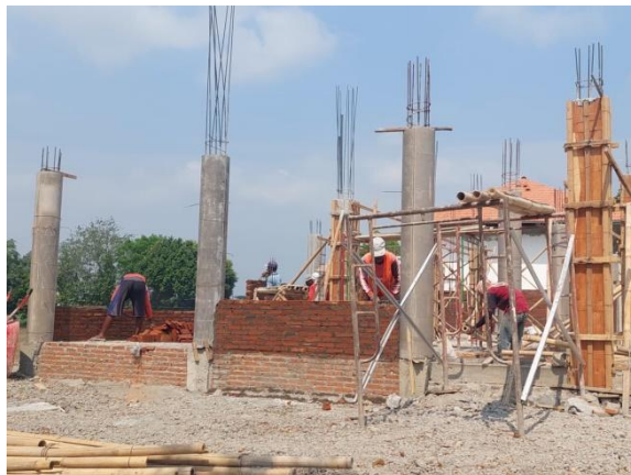
Gambar 4.24 Kolom Silinder (Sumber : Data Lapangan, 2023)
