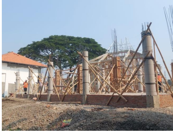
Gambar 4.22 Bekisting Kolom Silinder (Sumber : Data Lapangan, 2023)
