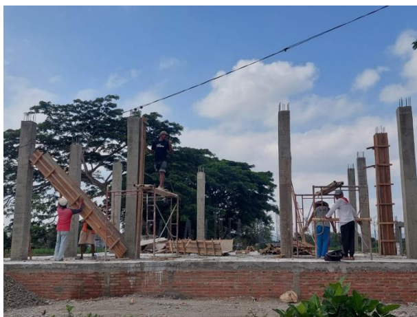
Gambar 4.19 Bekisting Kolom dilepas (Sumber : Data Lapangan, 2023)
