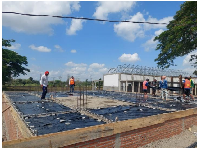
Gambar 4.13 Pemasangan plastik dan beton decking (Sumber : Data Lapangan, 2023)
