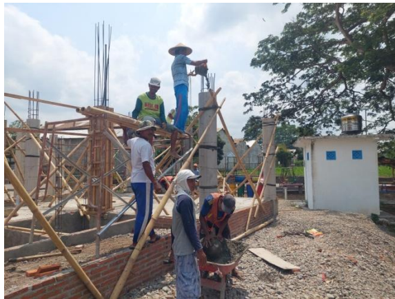
Gambar 4.23 Pengecoran Kolom (Sumber : Data Lapangan, 2023)
