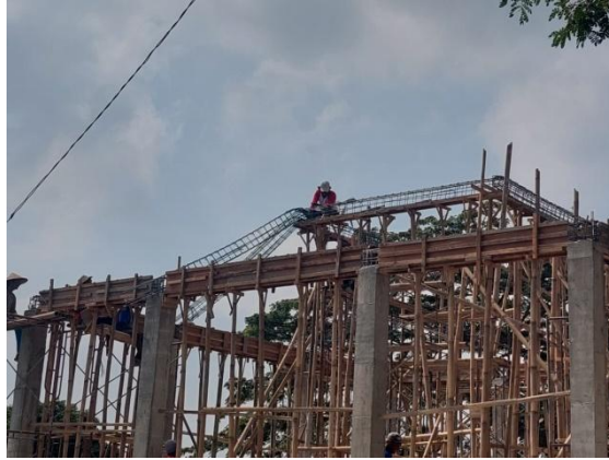
Gambar 4.27 Bekisting Balok Pendopo (Sumber : Data Lapangan, 2023)
