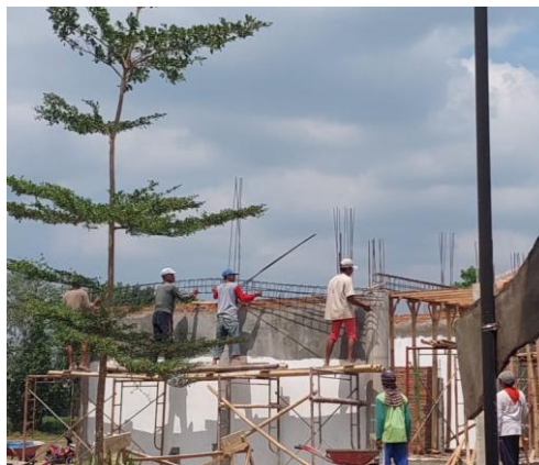
Gambar 4.26 Tulangan Balok Gedung Fasilitas Penunjang
