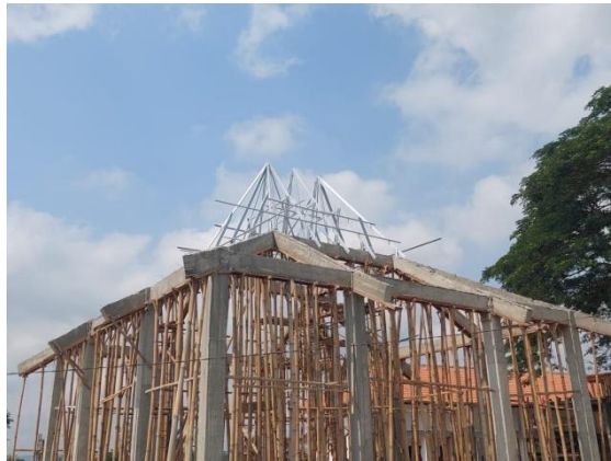
Gambar 4.28 Balok Pendopo (Sumber : Data Lapangan, 2023)
