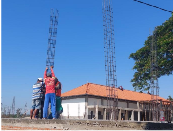
Gambar 4.17 Tulangan Kolom (Sumber : Data Lapangan, 2023)
