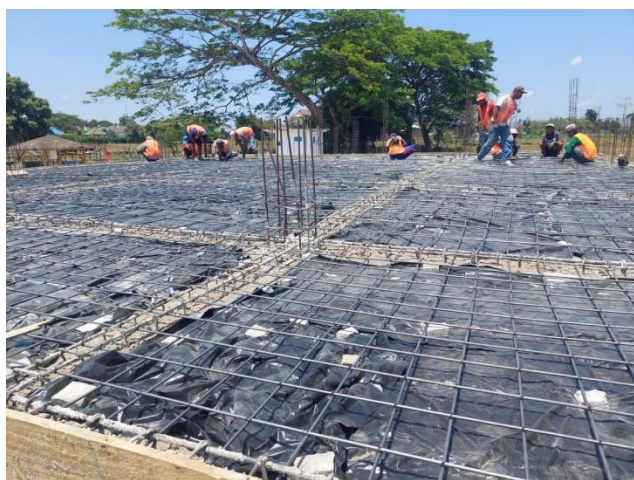
Gambar 4.14 Pemasangan Tulangan Plat lantai (Sumber : Data Lapangan, 2023)
