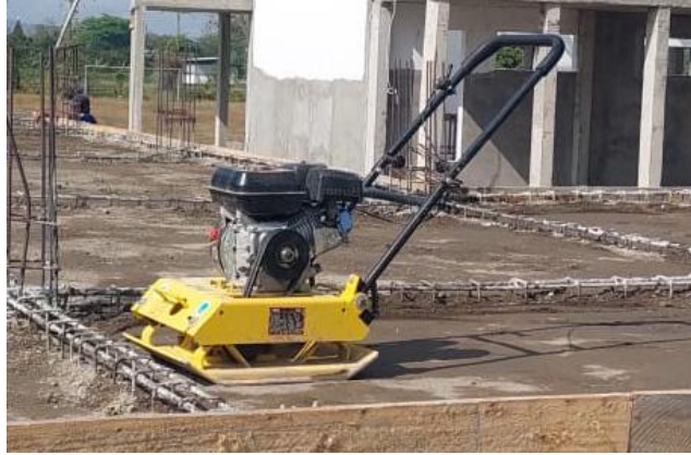
Gambar 4.12 Alat Pemadatan Tanah (Sumber : Data Lapangan, 2023)
