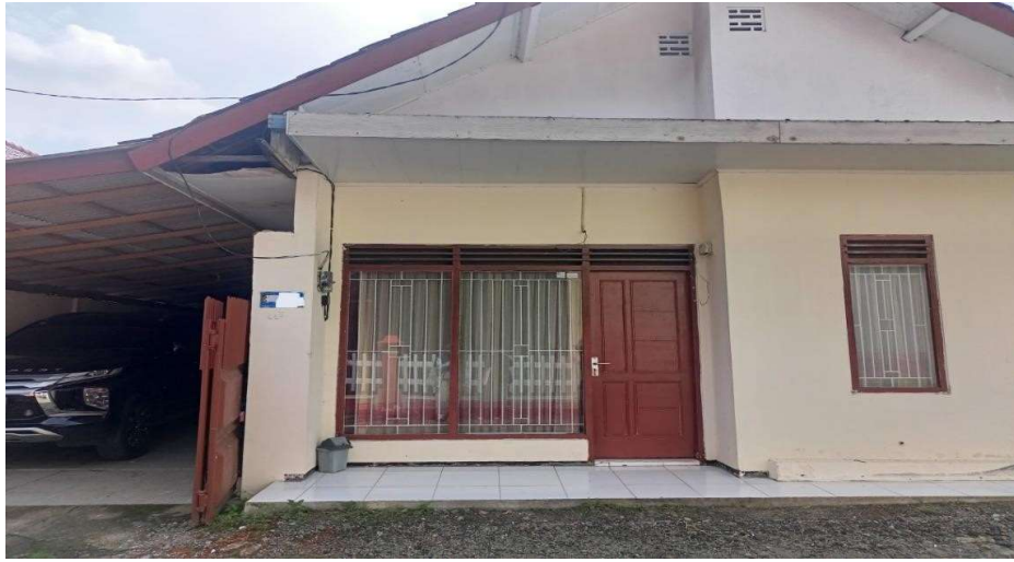
Dokumentasi 6. Keterangan: Fasilitas Rumah Aman ( Shelter ) UPTD PPA Kota Blitar
