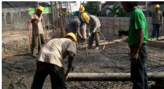
Gambar 4.29 Pengecoran plat ( Sumber : Kerja Praktek 2022 )
