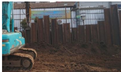
Gambar 4.23 Pekerjaan Sheet Pile ( Sumber : Kerja Praktek 2022 )
