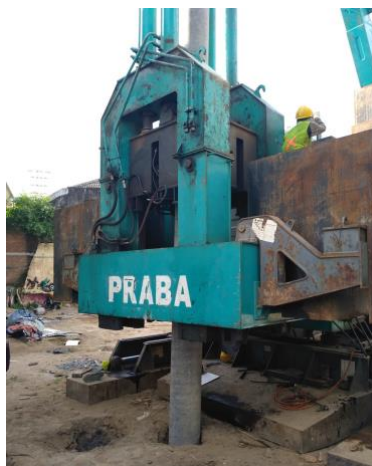
Gambar 4.24 Pekerjaan Pemancangan ( Sumber : Kerja Praktek 2022 )
