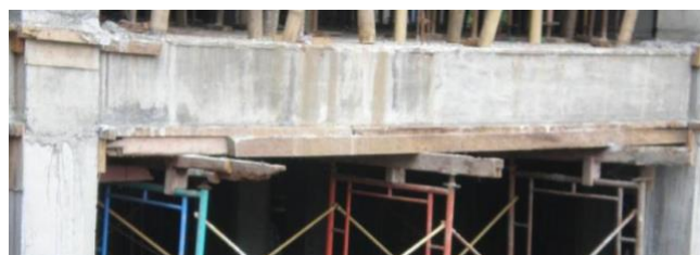
Gambar 4.28 Pengecoran balok ( Sumber : Kerja Praktek 2022 )
