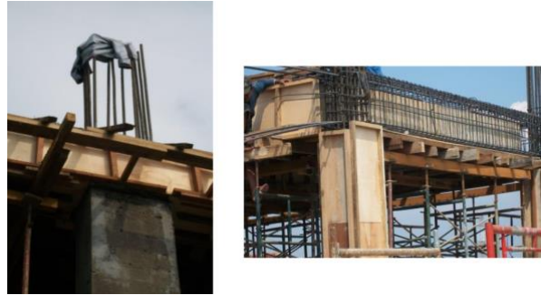
Gambar 4.27 Bekisting dan penulangan balok ( Sumber : Kerja Praktek 2022 )
