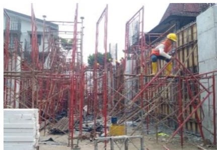
Gambar 4.12 Perancah ( Sumber : Kerja Praktek 2022 )
