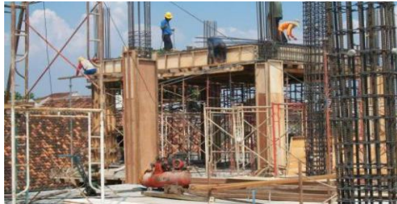
Gambar 4.26 Bekisting kolom (Sumber : Kerja Praktek 2022 )
