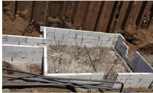
Gambar 4.25 Bekisting pile cap . (sumber: Kerja praktek, 2022)
