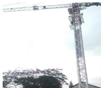
Gambar 4.19 Tower Crane ( Sumber : Kerja Praktek 2022 )
