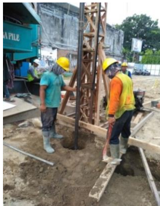
Gambar 4.30 Pengeboran titik tiang pancang ( Sumber : Kerja Praktek 2022 )
