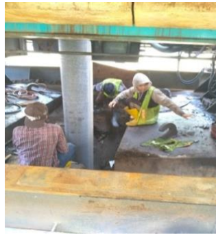
Gambar 4.31 Tiang Pancang saat Pile Load Test ( Sumber : Kerja Praktek 2022 )
