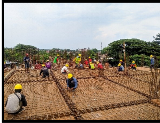
Gambar 4. 9 Penulangan plat lantai 3
