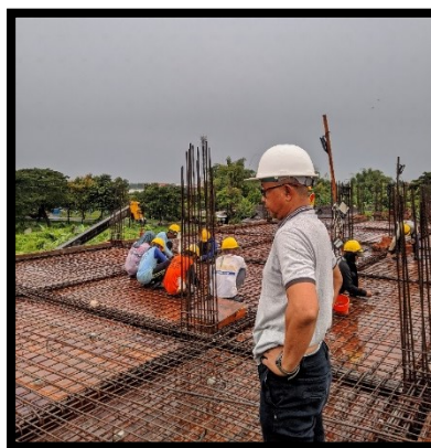
Gambar 4. 12 Proses Pengecekan Tulangan
