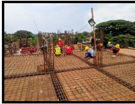
Gambar 4. 11 Proses Pemasangan Tulangan
