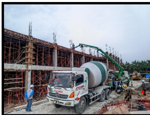
Gambar 4. 14 Proses Pengecoran Plat lantai dan Balok
