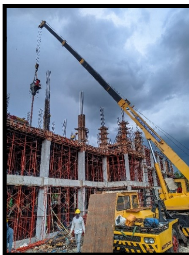
Gambar 4. 15 Proses Pengecoran Plat Lantai dan Balok Sebelum Hujan
