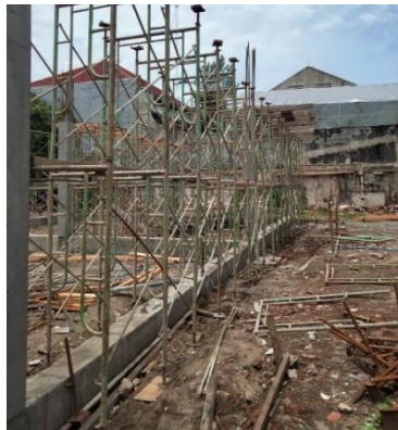
Gambar 4. 2 Pemasangan Perancah
