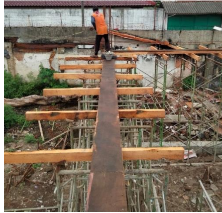
Gambar 4. 3 Pemasangan Bekisting
