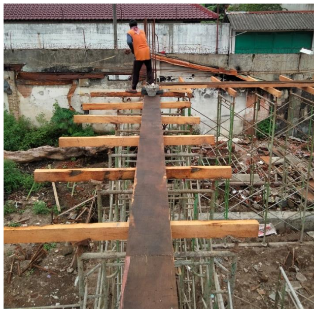
Gambar 2. 13 Pemberian oli/ pelumas pada bekisting
