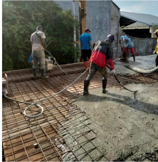
Gambar 2. 14 tahapan pengecoran pelat lantai pada proyek Gedung kantor bank mandiri
