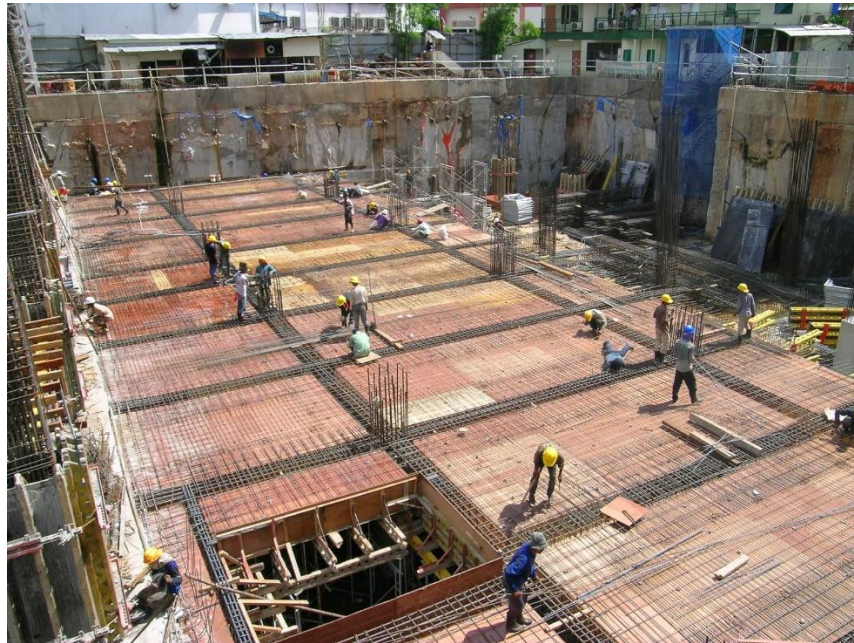
Gambar 2. 3 Pengerjaan pelat lantai konvensional
