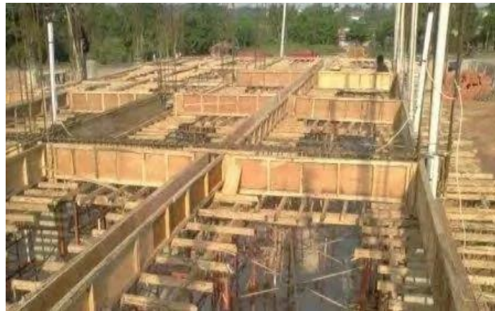
Gambar 2. 11 Contoh Pemasangan Bekisting
