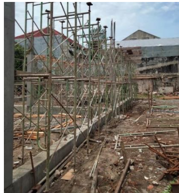
Gambar 4. 2 Pemasangan Perancah
