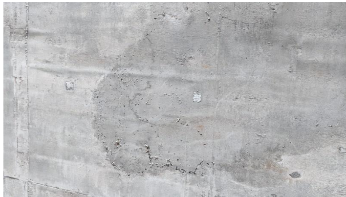
Gambar 4. 7 Hasil perbaikan permasalahan segregasi.
