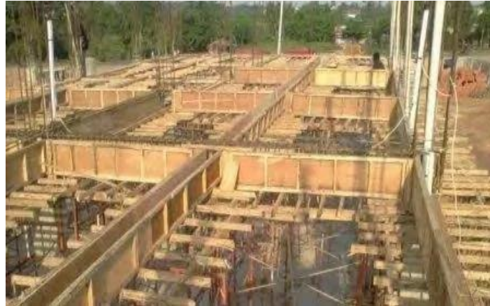
Gambar 2. 11 Contoh Pemasangan Bekisting
