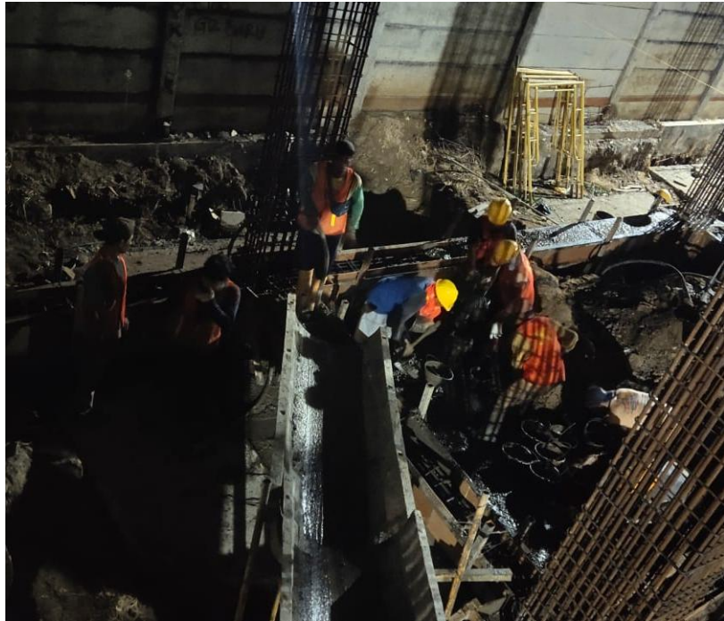
Gambar 4. 6 pengecoran Sloof dengan menggunakan ready mix Sumber : dokumentasi lapangan Selasa, 22 Februari 2022
