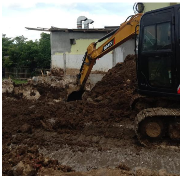
Gambar 4. 2 Pekerjaan galian tanah dengan alat pengeruk ( excavator ) Sumber : dokumentasi lapangan senin, 19 januari 2022
