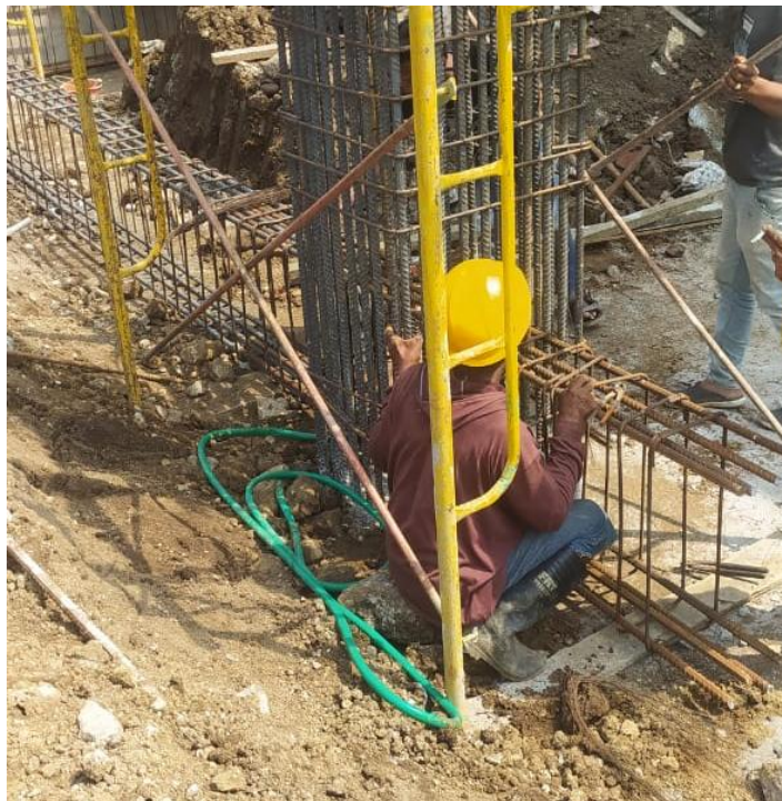
Gambar 4. 3 Pemasangan tulangan sloof Sumber : dokumentasi lapangan sabtu, 29 Januari 2020
