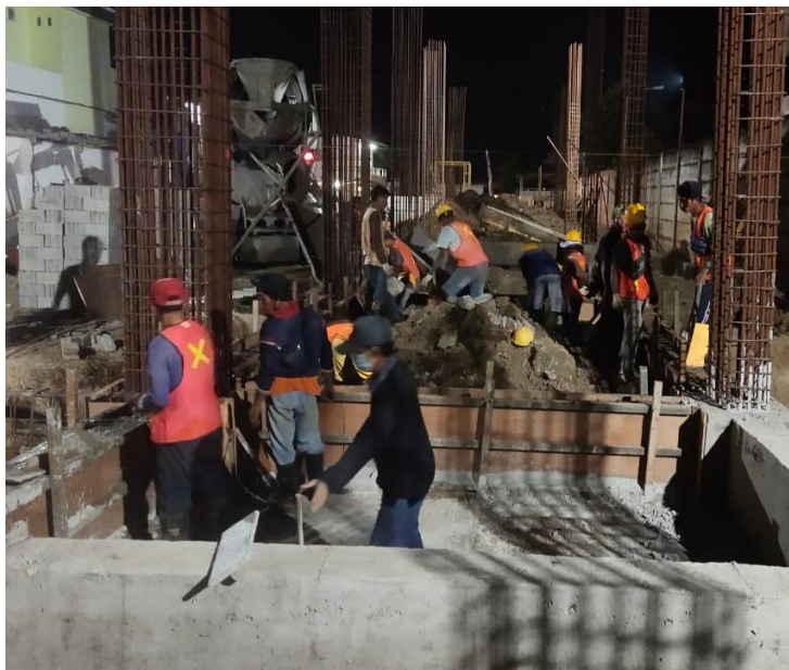
Gambar 4. 8 Pelepasan Bekisting Sloof
