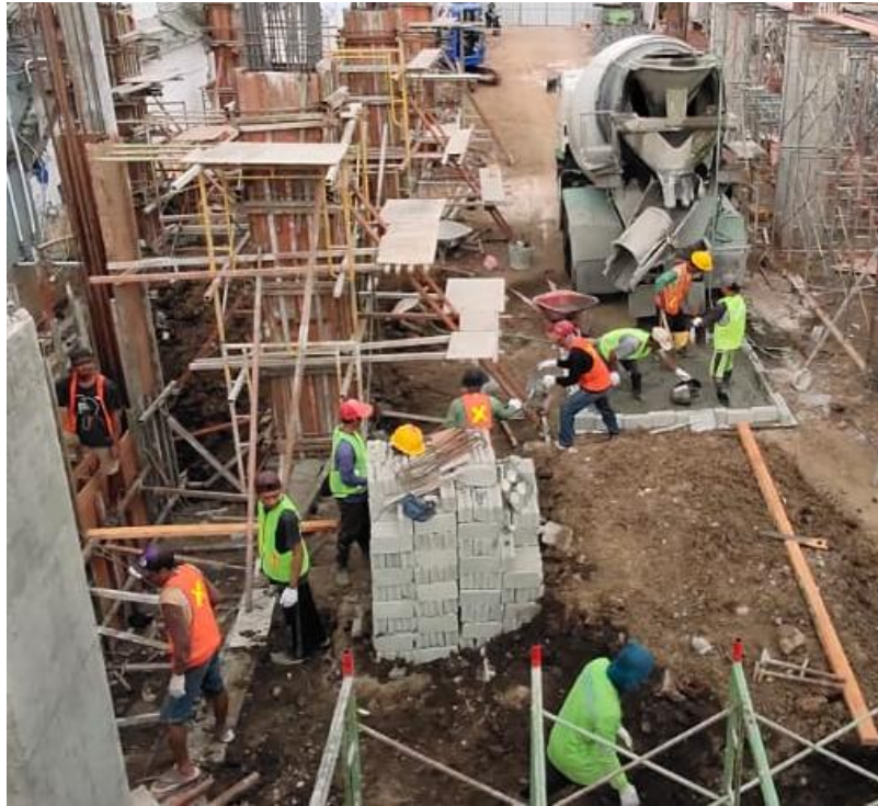
Gambar 4. 7 pengecoran Sloof.
