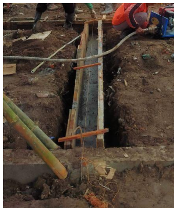
Gambar 4.4 Gambar Pemasangan bekisting sloof
