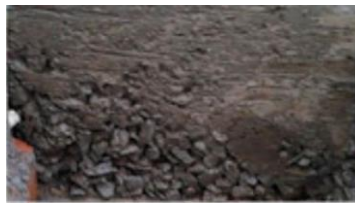
Gambar 2.16 Contoh segregasi pada sloof
