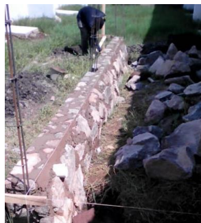
Gambar 2.12 Contoh Pondasi Batu Kali
