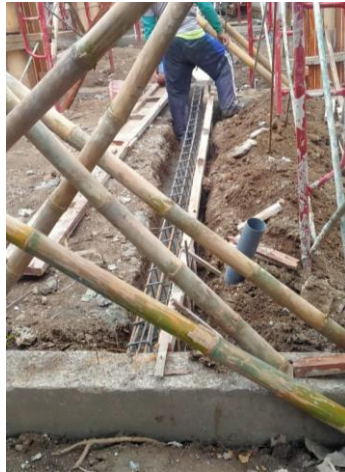
Gambar 4.3 Gambar Pemasangan Tulangan Sloof
