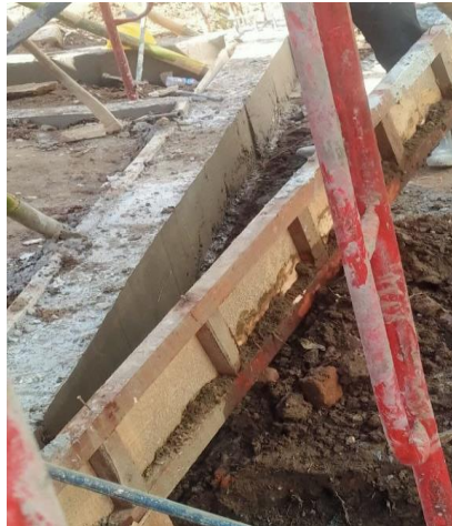
Gambar 4.6 Gambar Pelepasan bekisting sloof
