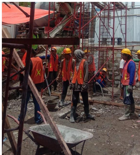
Gambar 4.5 Gambar Pengecoran sloof
