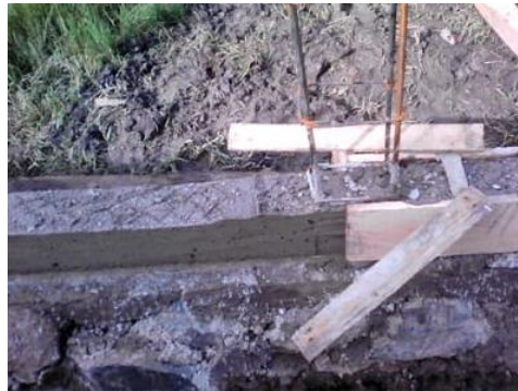
Gambar 2.15 Contoh Pelepasan Begisting
