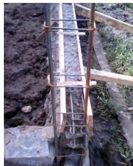
Gambar 2.14 Contoh Pengecoran Sloof
