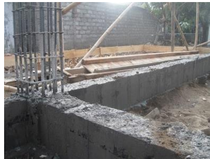
Gambar 2.9 Contoh Sloof beton bertulang
